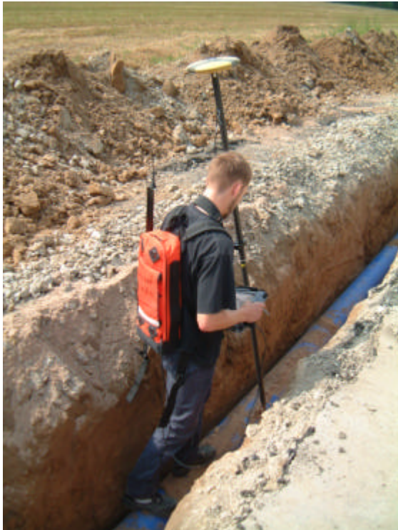
Bild 1: GPS-Vermessung eines Grabens
