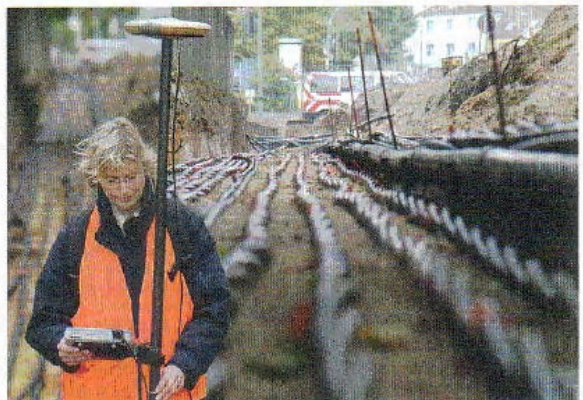
Mit Satellitenvermessungstechnik erfasst – Stromleitungen in und um Osnabrück; nach kurzer Einweisung problemlos zu handhaben: Satellitenvermessung per DGNSS-Gerät. Fotos: E.ON Ruhrgas/Bildmontage Scheerer
