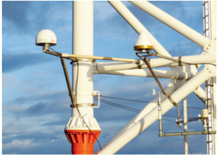
GNSS-Referenzstation auf der FINO-3
