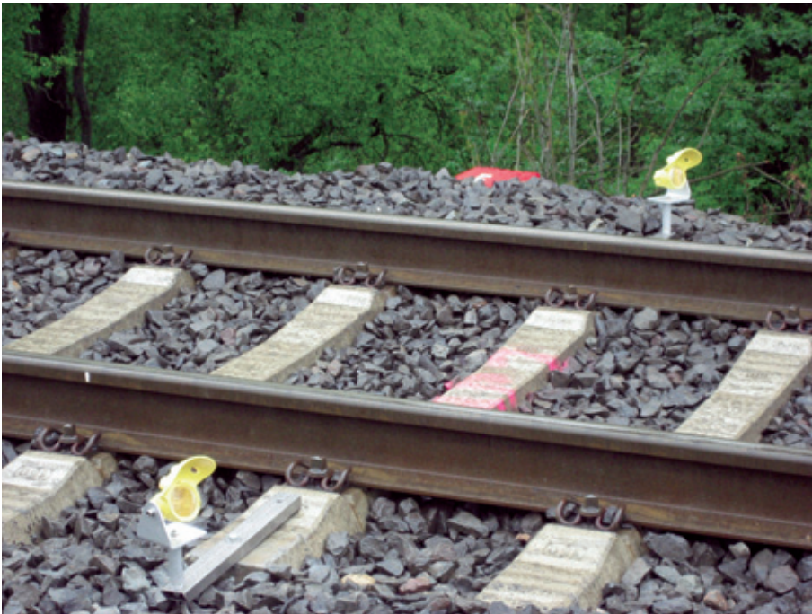
Abb. 4: Überwachungs-Prismen an den Gleisschwellen
