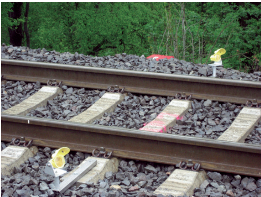
Abb. 4: Überwachungs-Prismen an den Gleisschwellen
