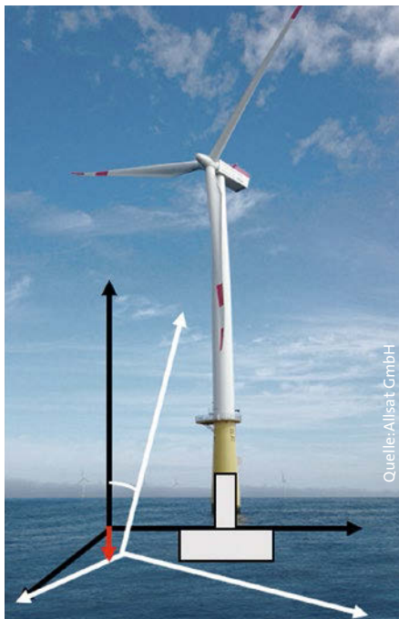
GNSS-Monitoring von Windkraftanlagen
